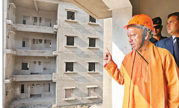
निर्माणाधीन खेल विश्वविद्यालय का निरीक्षण करते मुख्यमंत्री योगी।
